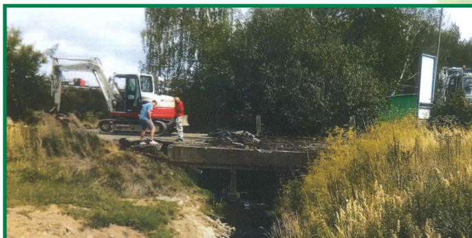
Stavba nového mostu.
